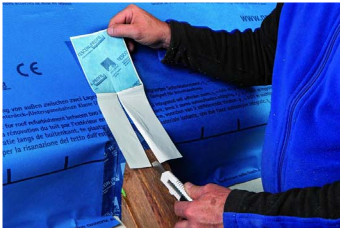
Das neue TESCON SANAPATCH – perfekt für die Anwendung im Bereich von Kernen und bei Rohren, die sehr nah an angrenzenden Bauteilen liegen.
