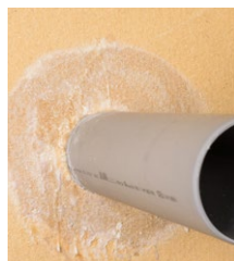
Holzfaslerplatte mit TESCON SPRIMER vorbehandeln
