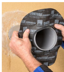
Manschette über das Rohr ziehen ...
