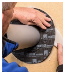
Manschette mit dem Untergrund verkleben
