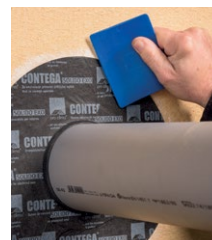
Gleichmäßig mit dem PRESSFIX anreiben
