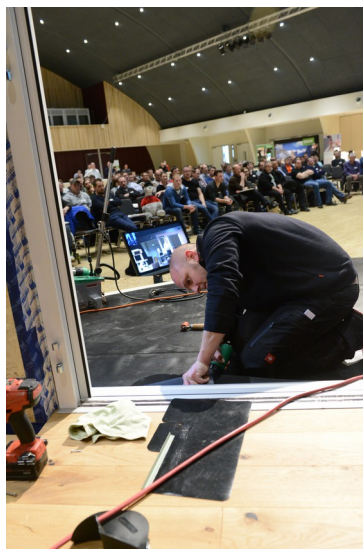
Barrierefreier Zugang auf eine Dachterrasse: Das Team von Schnittstelle Baustelle demonstrierte in Blaubeuren, wie verschiedene Anschlüsse fachgerecht geplant und hergestellt werden.
