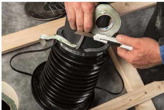
Die patentierte Rohrdurchführung WILLFIX zur sauberen Herstellung von dauerhaft sicheren Luft- und Winddichtung bei Aufdachdämmungen aus druckfesten Dämmstoffen.
