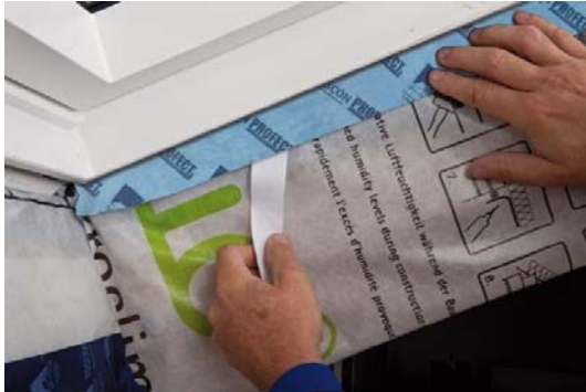
TESCON PROTECT: Vorgefaltetes Winkelanschlussband, z.B. für die Verklebung von Anschlüssen an angrenzende Bauteile, wie Fenster, Türen usw., innen und außen
