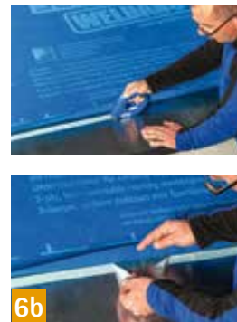
DUPLEX Doppelseitiges Klebeband für Verklebung der Bahnenkopfstöße und Anschlüsse
