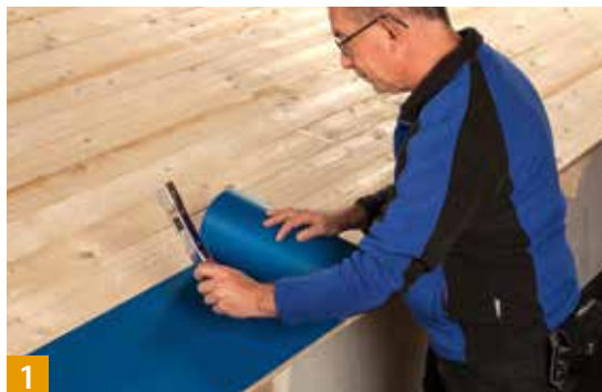
SOLITEX WELDANO-S Diffusionsoffener, wasserdicht verschweißbarer Unterdach- bahnstreifen
