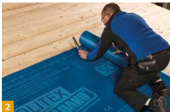
SOLITEX WELDANO Diffusionsoffene, homogen verschweißbare Unterdachbahn
