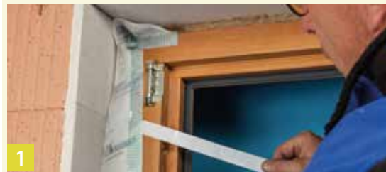
EXTONSEAL ENCORS Wasserführendes Anschlussklebeband mit hoher Klebkraft
