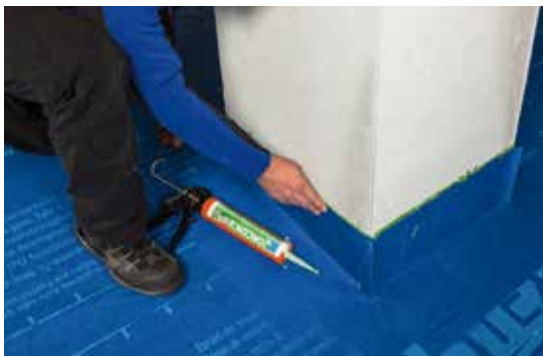
WELDANO INCAV / INVEX Homogen verschweißbares Innen- ecken-/Außen-Formteil im SOLITEX WELDANO-Unterdachsystem
