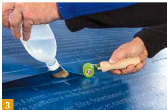
WELDANO TURGA Quellschweißmittel im SOLITEX WELDANO-Unterdachsystem
