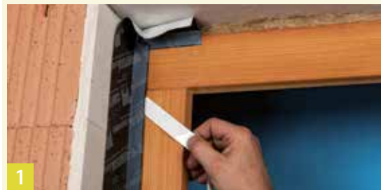
EXTOSEAL ENCORS Wasserführendes Anschlussklebe- band mit hoher Klebkraft
