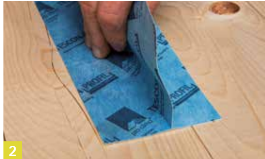
TESCON VANA Zur Verklebung der Bahnenüberlappungen
