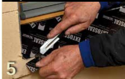
5 Waagerechten Überstand vom Band mit Hilfe einer Zulage bis auf 15 mm zurückschneiden damit das Band später über den Putz greift.
