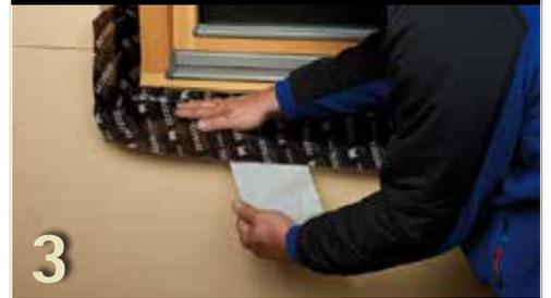
3 Mittlere Trennfolie Stück für Stück ablösen und Band Zug um Zug in der Leibung verkleben. Dabei das Band exakt in die Ecken führen. Anschließend überall fest anreiben.
