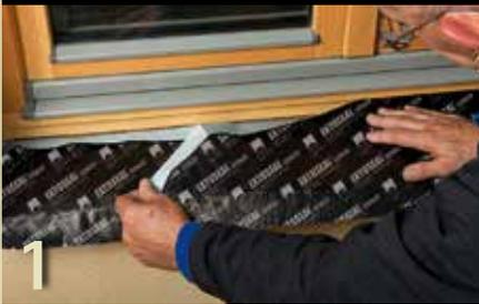
1 Band abmessen (Öffnungsweite + 2x 20 cm) und abschneiden. Schmale Trennfolie nach und nach ablösen und Band Zug um Zug am Blendrahmen im Fensterbankfalz verkleben.
