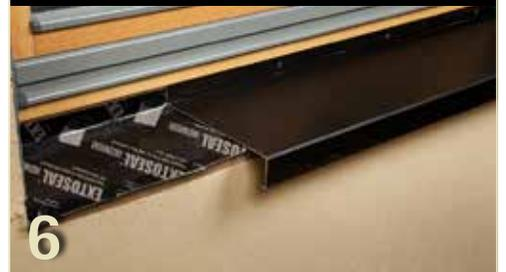
6 Fertige Unterfensterbank aus EXTOSEAL ENCORS. Folgegewerk Putz klebt die Anputzleiste an das überstehende Stück Band. Endgültiger Schutz der Leibung durch Einbau einer Fensterbank.
