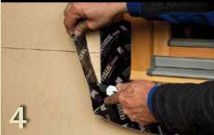
4 Überstehendes Band an den senkrechten Leibungen vorderkantenbündig mit der Holzfaserdämmplatte abschneiden.
