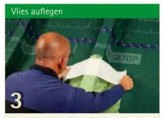
Vlies vollflächig in den Dichtstoff einlegen. Vliesränder erforderlichenfalls mit weiterem Dichtstoff bestreichen. Bei großen Flächen Vliesstücke nach und nach überlappend einlegen. Überlappungen mit Dichtstoff verkleben.
