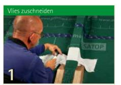
Vlies in der erforderlichen Länge abschneiden. Die abzudichtende Fläche damit probeweise auslegen. Bei zergliederten Flächen ggf. mehrere Vliesstücke verwenden.
