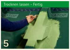
Fertig abgedichteter Anschluss. Trocken nach ca. 2,5 bis 3,5 Stunden (bei 20 °C und 60 % rel. Luftfeuchte)
