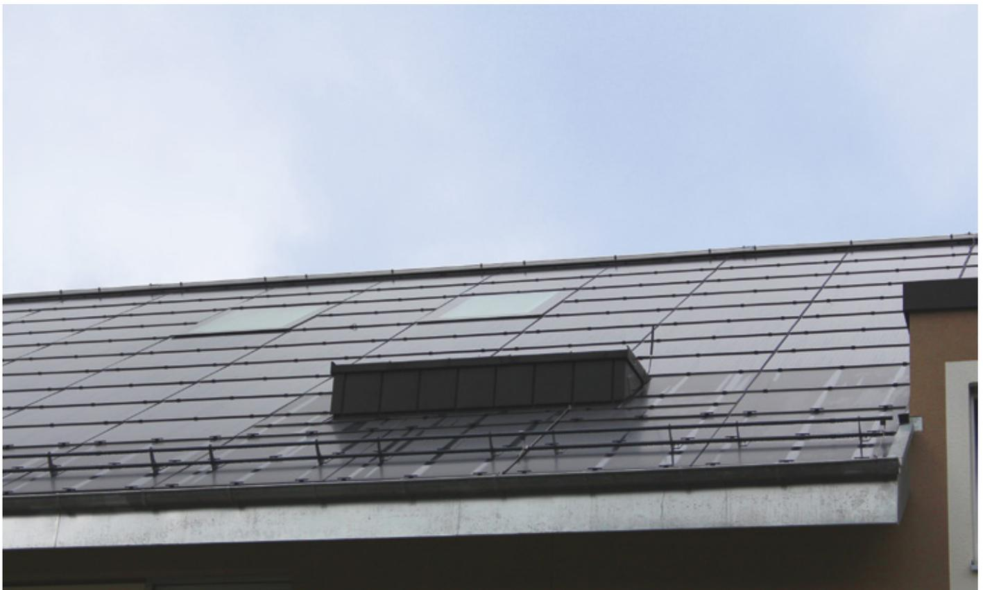
Integrierte PV-Anlage mit Unterdach MENTO 3000 connect
