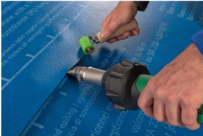
Die SOLITEX WELDANO ist homogen verschweißbar mit Quellschweißmittel oder Heißluft
