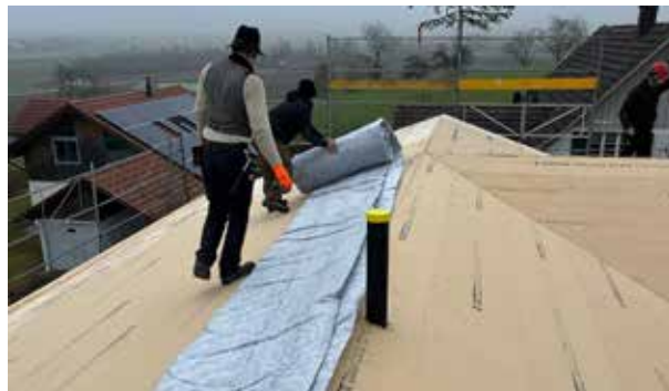
Déroutage de la bâche.
