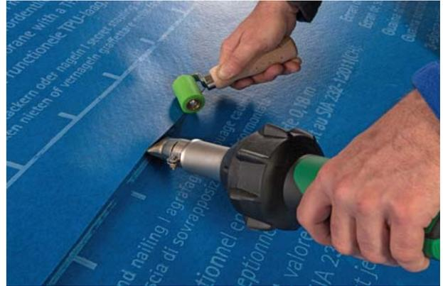
SOLITEX WELDANO - Ecran de sous-toiture ouvert à la diffusion, permettant un soudage homogène
