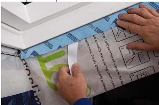
La nouvelle bande de raccord TESCON PROTECT est pré-pliée et l'un des côtés est prêt-à-coller.
