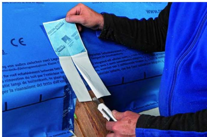
Le nouveau TESCON SANAPATCH convient parfaitement autour des entailles et des conduits tout proches d'éléments de construction adjacents.
