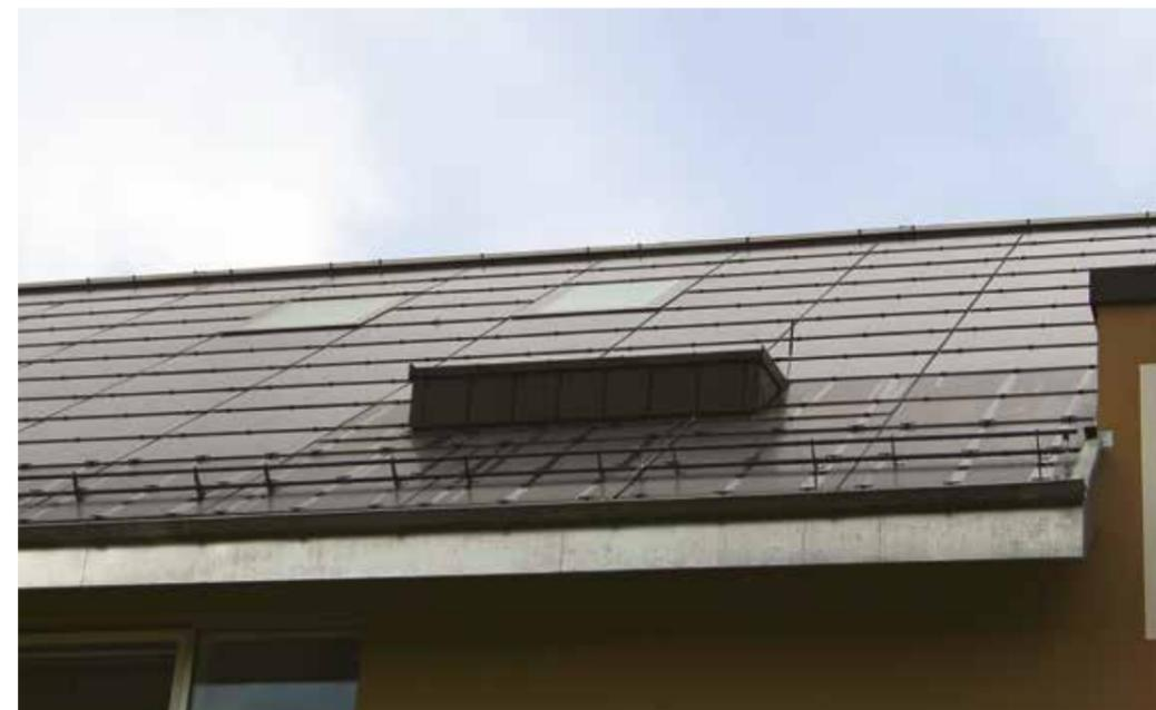
Installation photovoltaïque intégrée, avec sous-toiture MENTO 3000 connect
